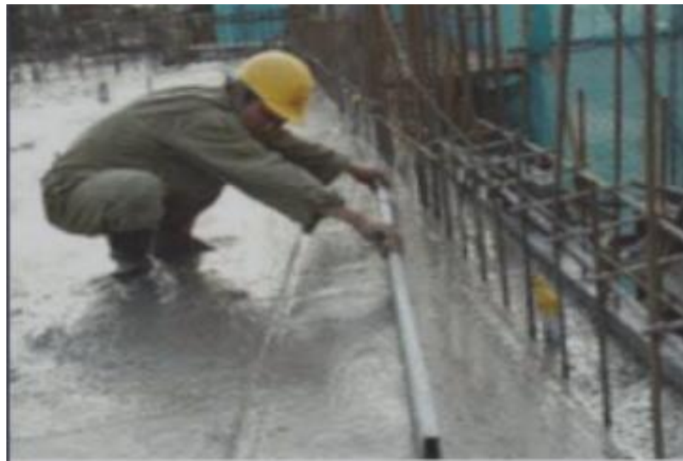
沿四周墙的墙根处向中间刮平 （ 效果检查 ）
