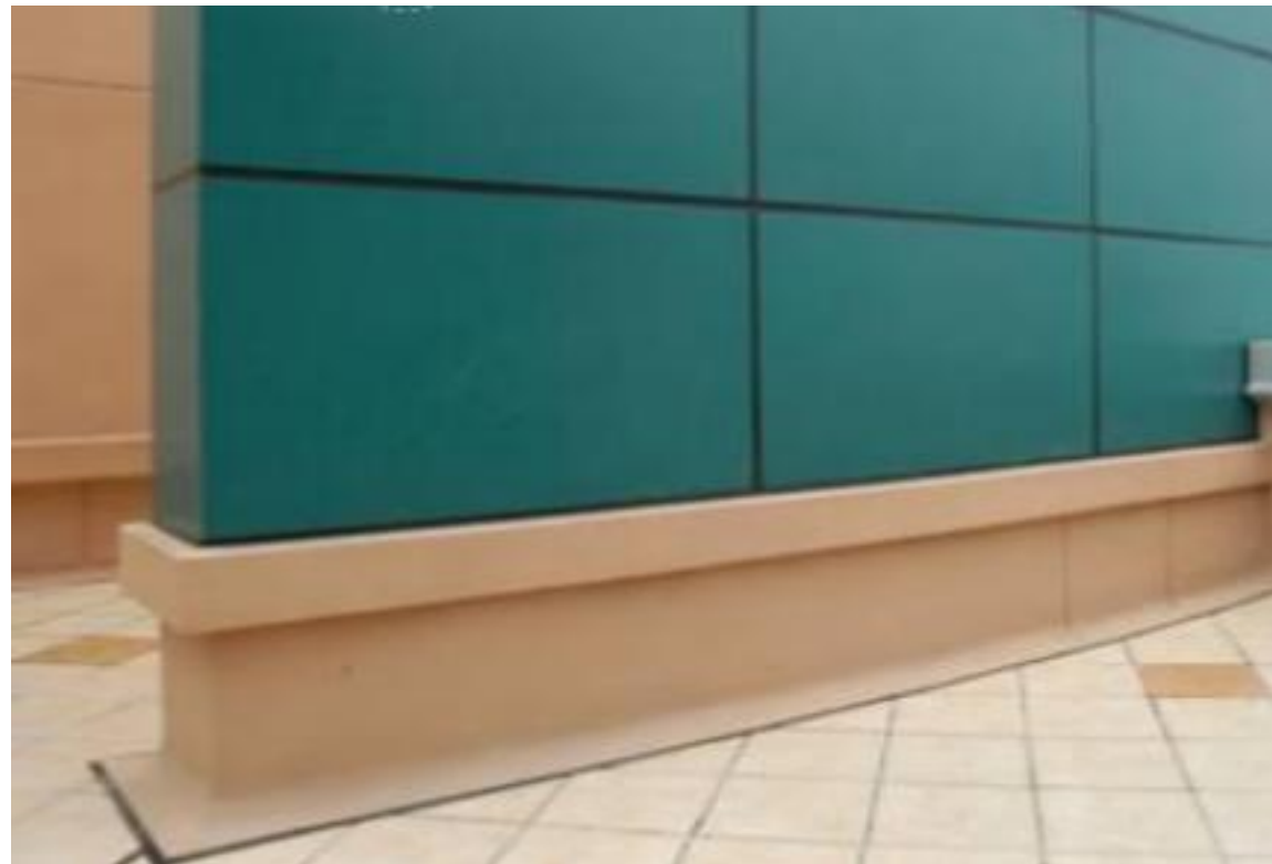
结构刚性泛水条
