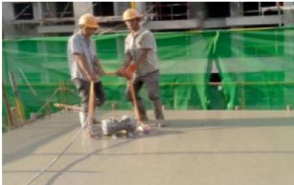
平板振动器振平（ 效果检查 ）
