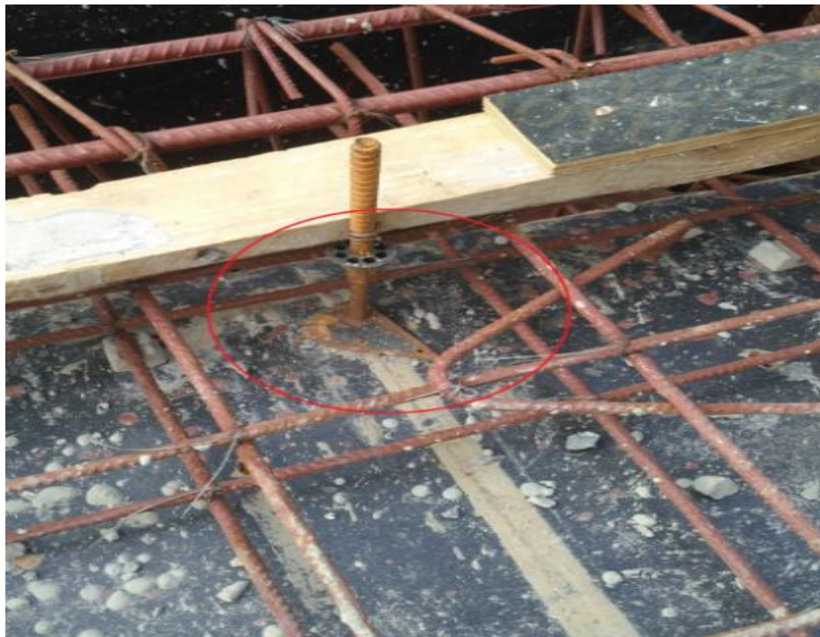
木方吊模用可拆头止水 螺杆支撑实例
