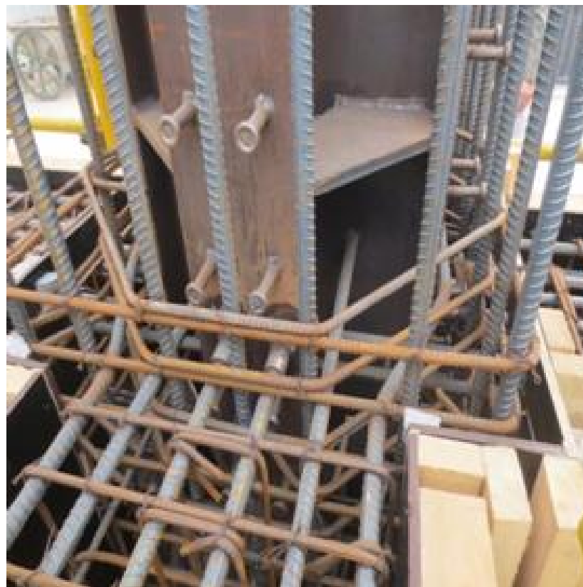
开模安装复杂节点核心区 钢筋效果
