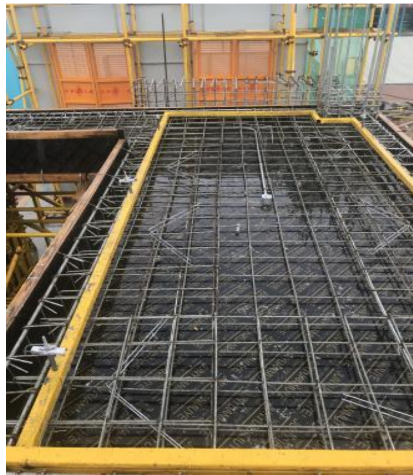
钢吊模可拆头止水螺杆支撑
