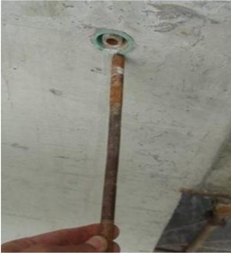
支承固定上层墙模用 可拆卸螺栓
