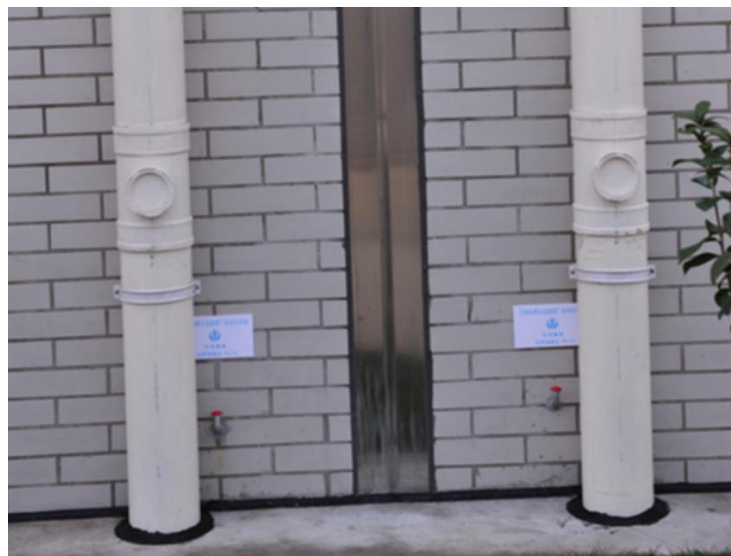
变形缝两侧均设沉降观测点
