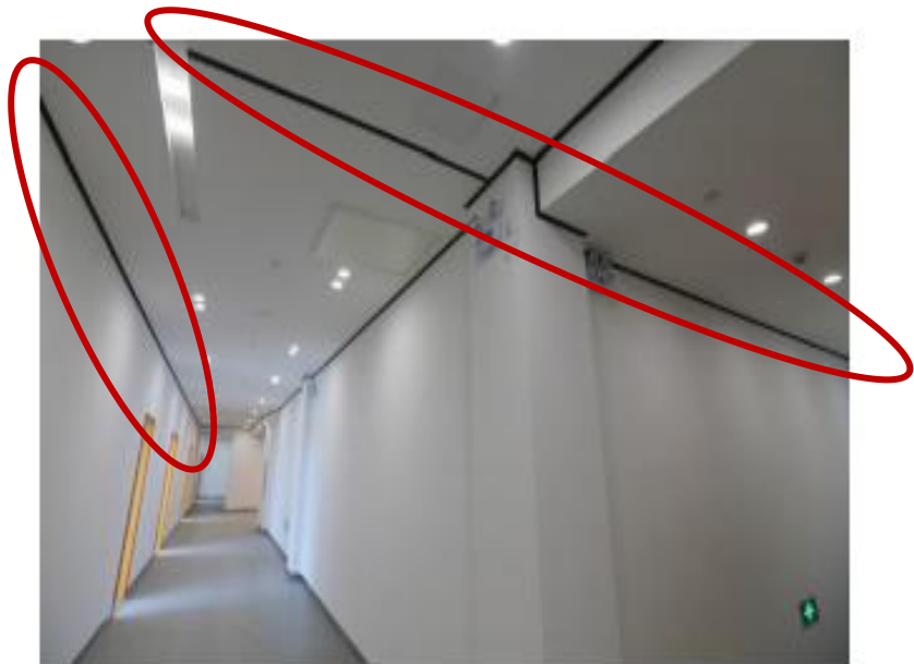
石膏吊顶设置分隔线条
