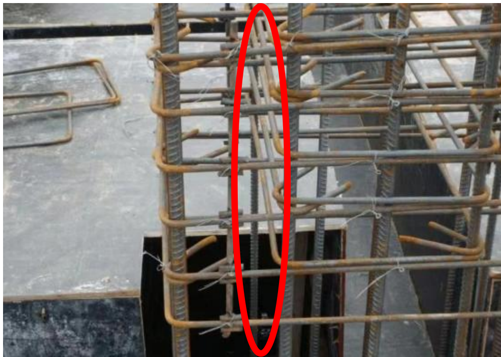
柱头箍定位用蜈蚣状定位辅助筋例图
