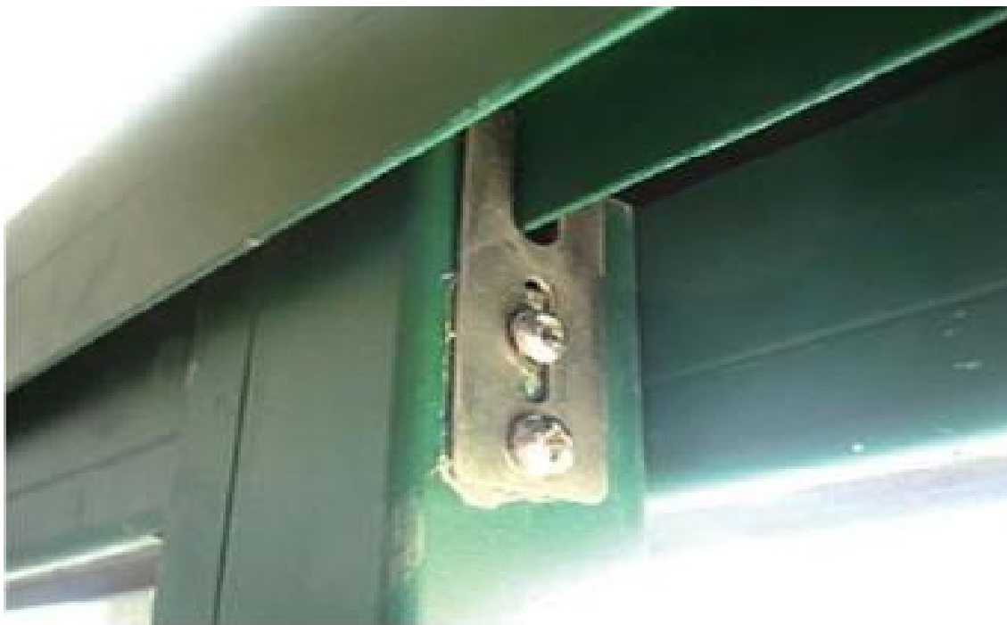
推拉窗防脱落装置
