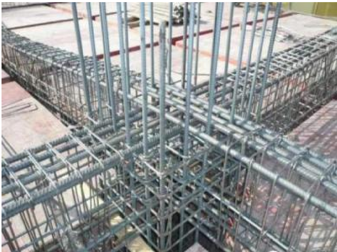
辅助筋使用后柱头钢筋安装 到位效果图
