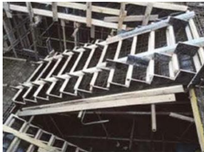
楼梯模板外邦三角板和中帮反三角板示意图及实例
