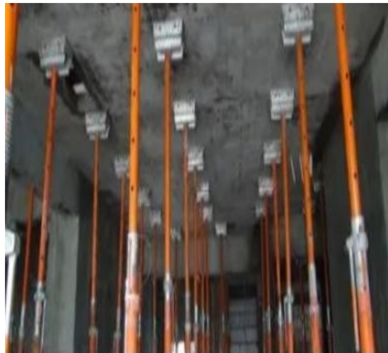
现浇楼板早拆梁板模板时支撑杆垂直无松动
