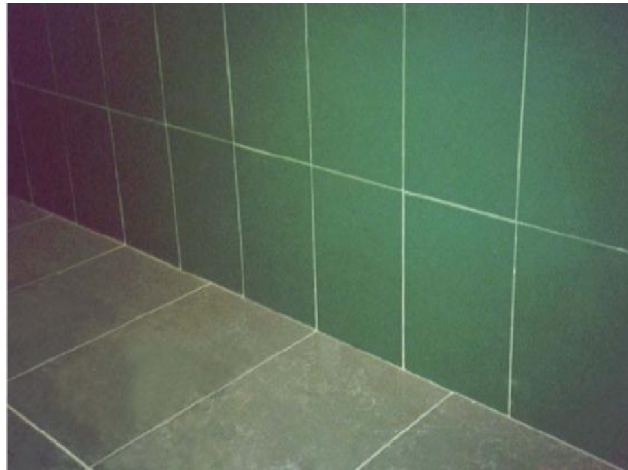
地砖与墙砖隔块对缝
