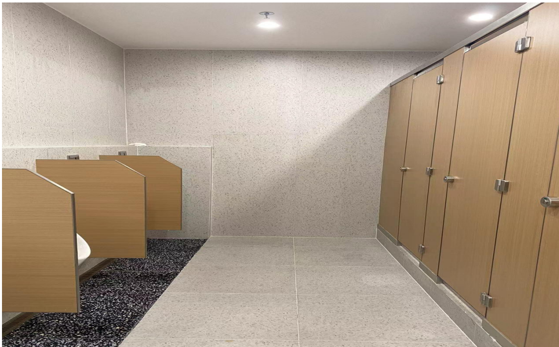
墙砖、地砖、吊顶、经纬线对齐
