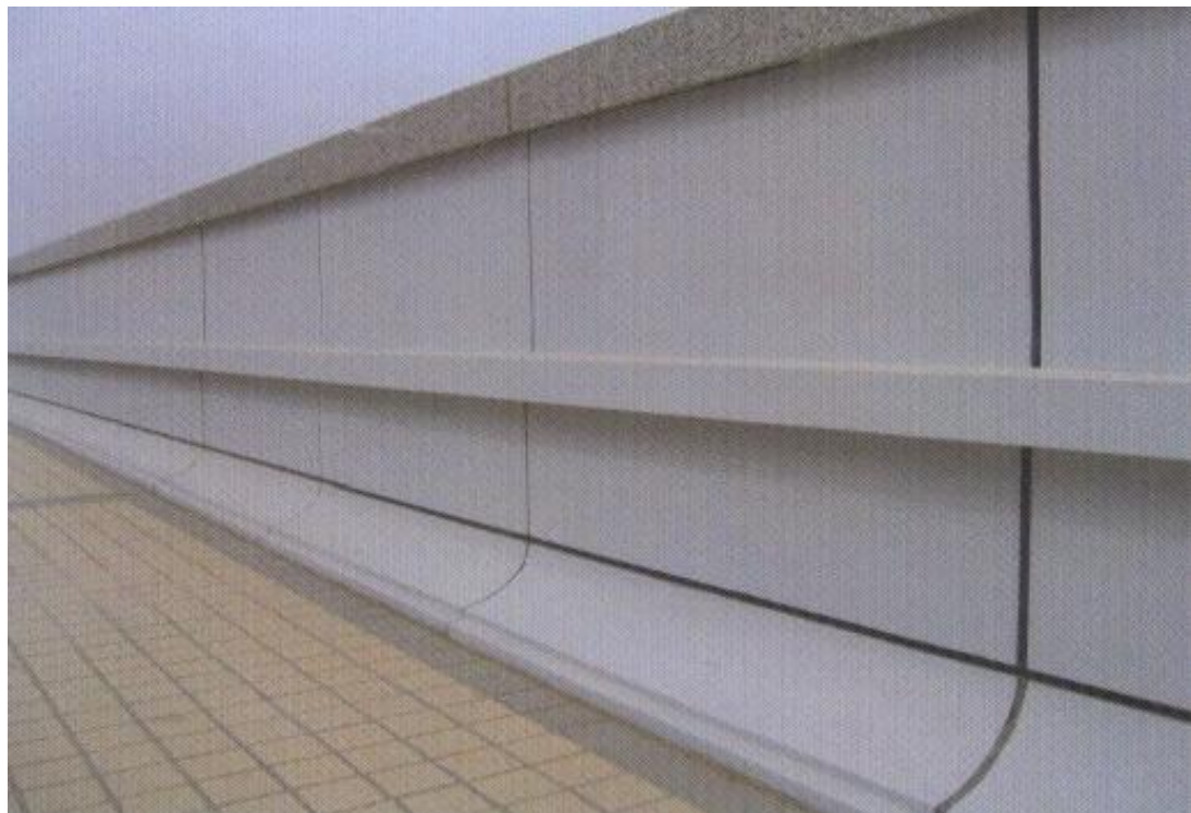
分隔缝宜采用耐候胶
