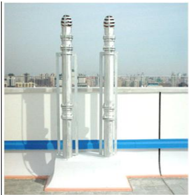
出屋面管根细部做法效果 (加基础墩)
