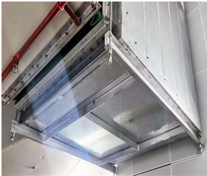
双螺母和弹簧垫圈问题
