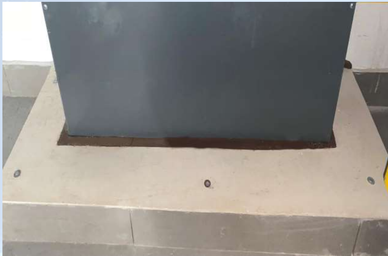
线槽防火封堵问题
