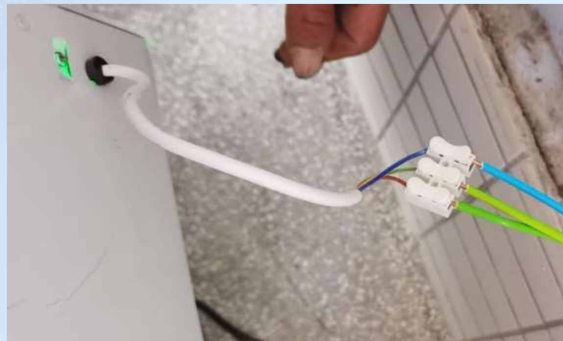
硬线、软线连接问题
