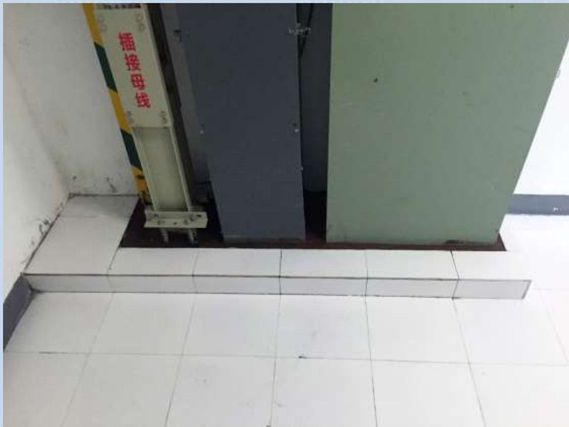
线槽防火封堵问题
